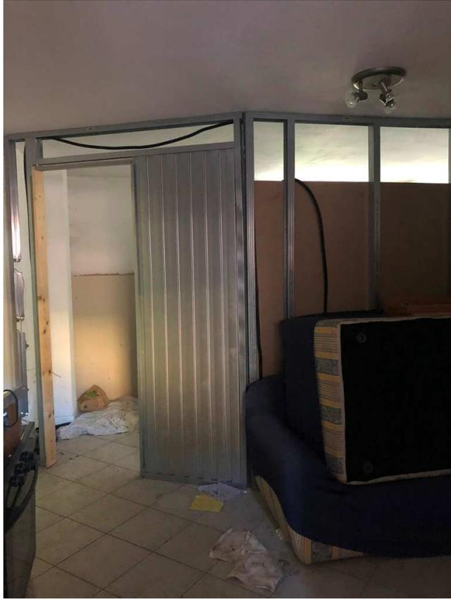
Figura 25 interno cantina con parete in cartongesso in fase di realizzazione
